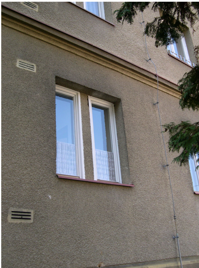
Pohled z exteriéru na okno do předsíně a WC + pohled na větrací štěrby do spíže
