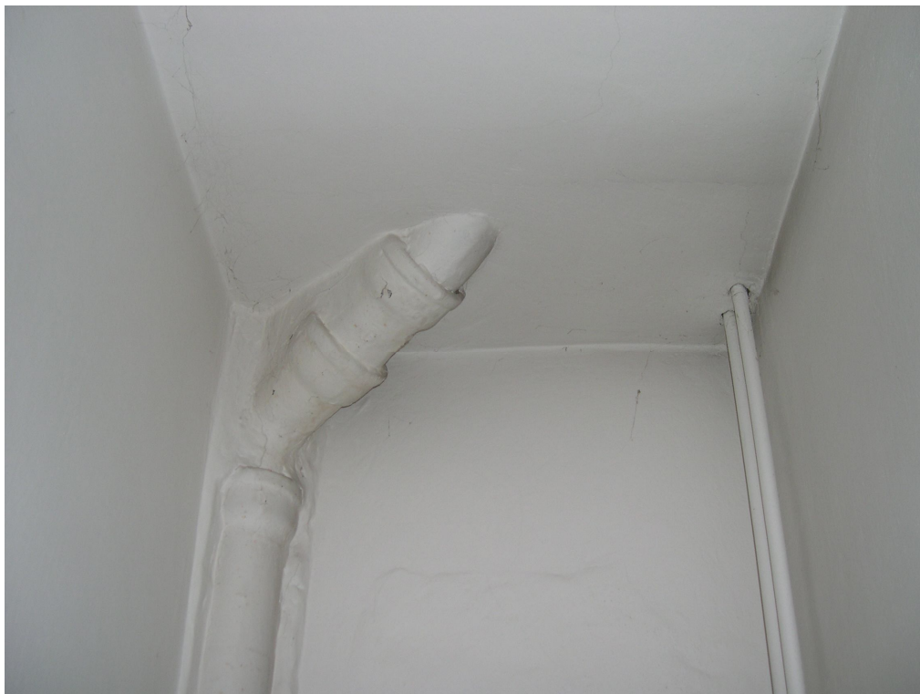
Trasa stoupačky splaškové kanalizace na WC
