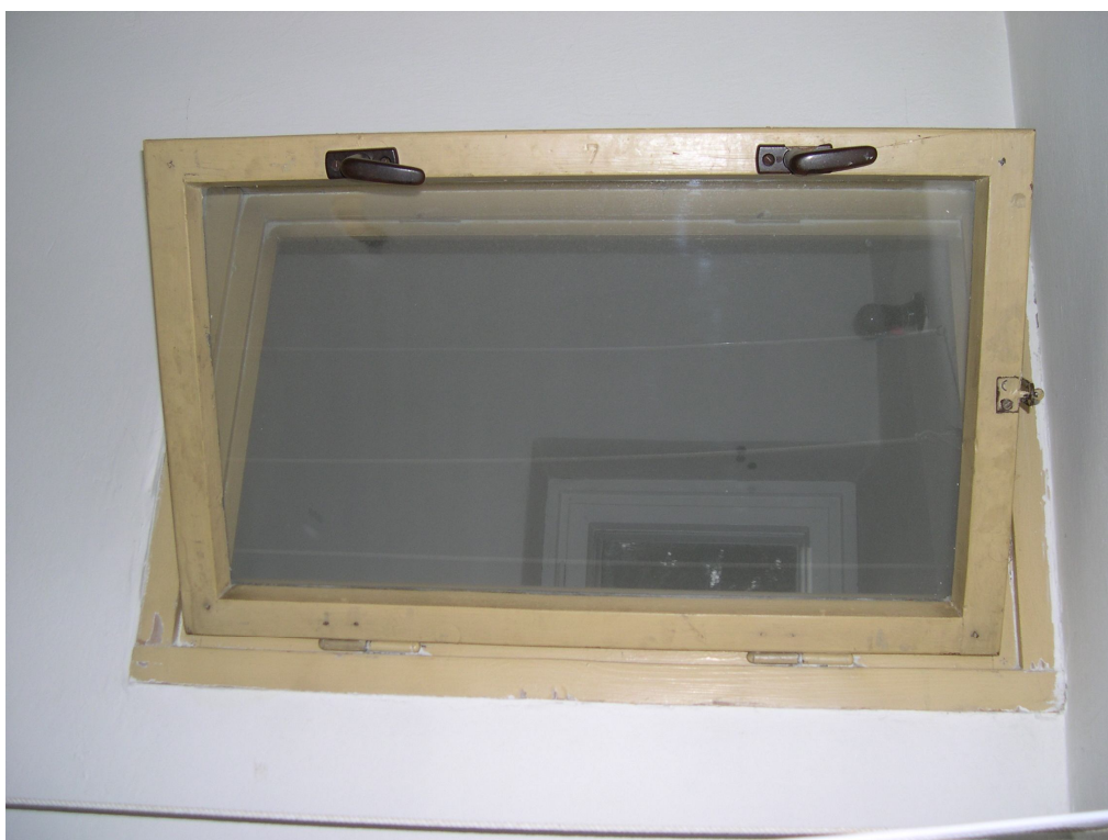
Okno ve stěně mezi koupelnou a WC
